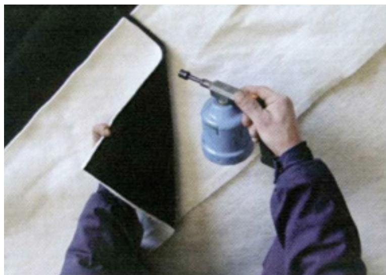
Thermo fixation au chalugaz portatif
