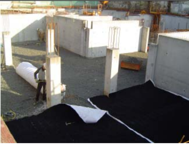
Recouvrement latéral par simple recouvrement grâce à la bavette filtrante prévue à cet effet
