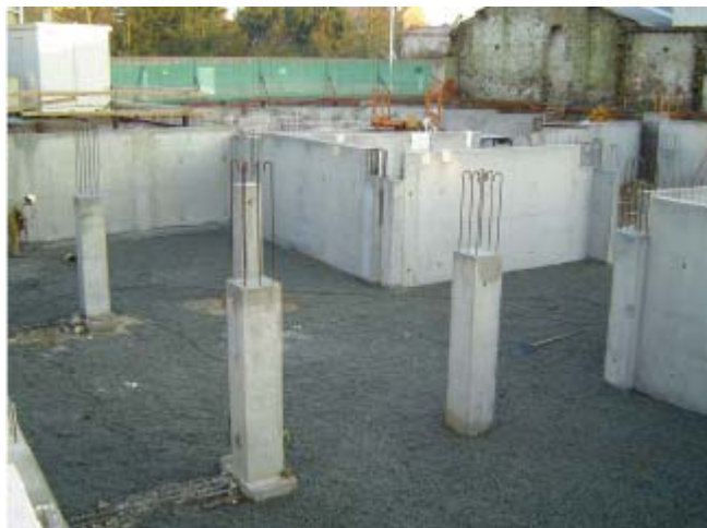
Préparation du fond de forme recevant le Teradrain
