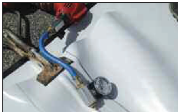
contrôle de soudure à l'air comprimé
