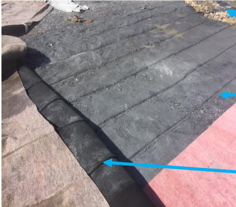
Evacuation du réseau des mini-drains teradrain® dans une tranchée drainante en 40/80.
