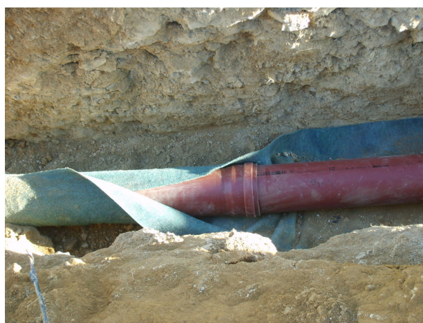
Mise en place du géotextile de protection en fond de tranchée
