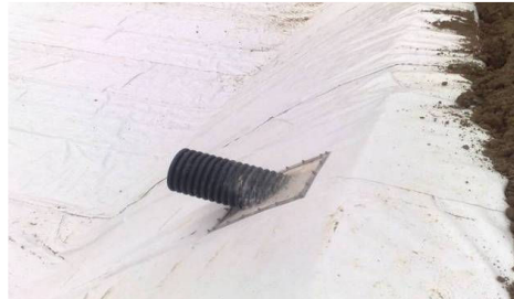
Raccord de l'étanchéité aux ouvrages béton
