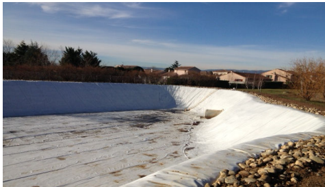
Etanchéité du bassin par géomembrane teraline
