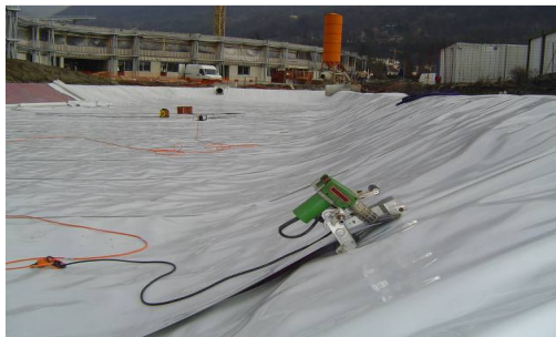
Soudure par soudeur certifié Asqual
