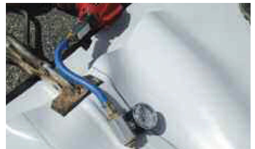
Contrôle des soudures à l'air comprimé
