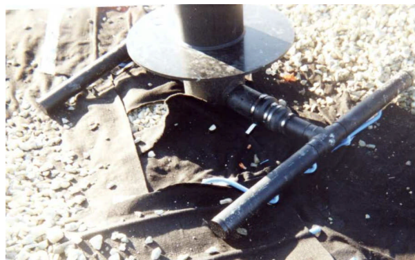
Système de raccord des bandes Teradrain® aux événements
