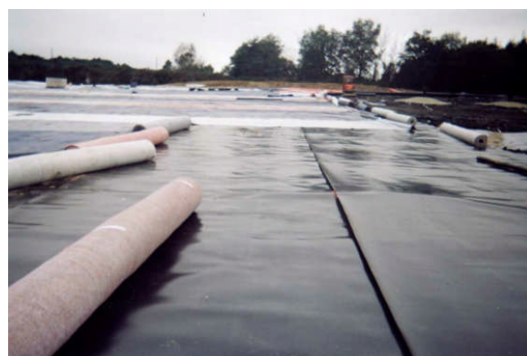
Géomembrane en tuilage et géotextile anti poinçonnant
