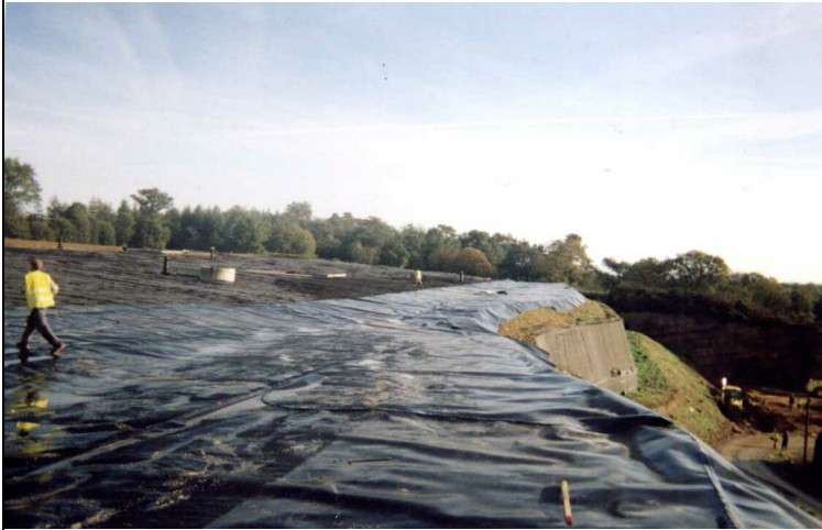
Ph 2 : Pose de l'étanchéité sur la couverture
